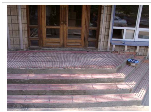
Рис. 3. Монтаж нагревательного кабеля Deviflex™ DSIG-20 в теплице и на открытой площадке.
