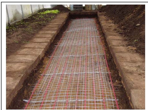
Рис. 3. Монтаж нагревательного кабеля Deviflex™ DSIG-20 в теплице и на открытой площадке.
