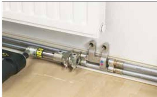
Рис. 16-33 Соединение с помощью подвижной гильзы, трубы диаметром 16 мм, с крестовиной из комплекта SL- RAUTITAN 16 - 12 - 16
