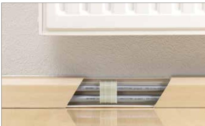
Рис. 16-24 Фиксация труб отопительной системы в плинтусном канале RAUSOLO
