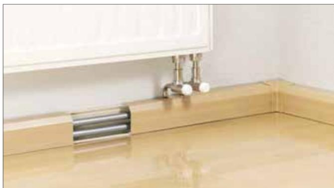
Рис. 16-44 Установленный плинтусный канал RAUSOLO с присоединительными трубками SL-RAUTITAN
