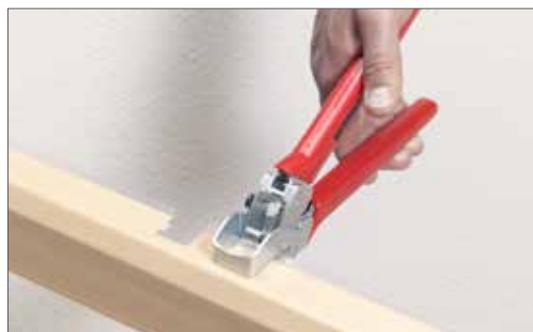
Рис.16-39 Вырезка прямоугольных отверстий в крышке плинтусных каналов
