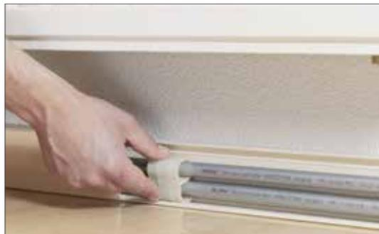
Рис.16-36 Установка фиксаторов труб отопительной разводки
