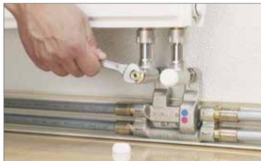
Рис. 16-38 Прочно затяните резьбозажимное соединение.
