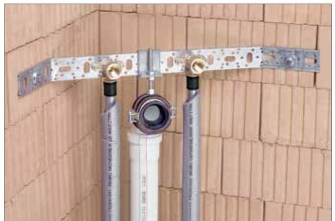
Рис. 5-3 Пример монтажа кронштейна
