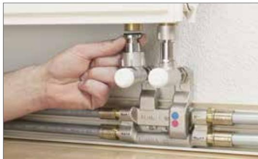
Рис. 16-37 Подключение угловых телескопических резьбозажимных соединений к отопительному прибору
