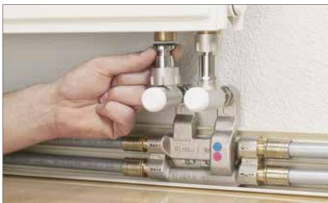
Рис. 16-26 Подключение угловых телескопических резьбозажимных соединений
